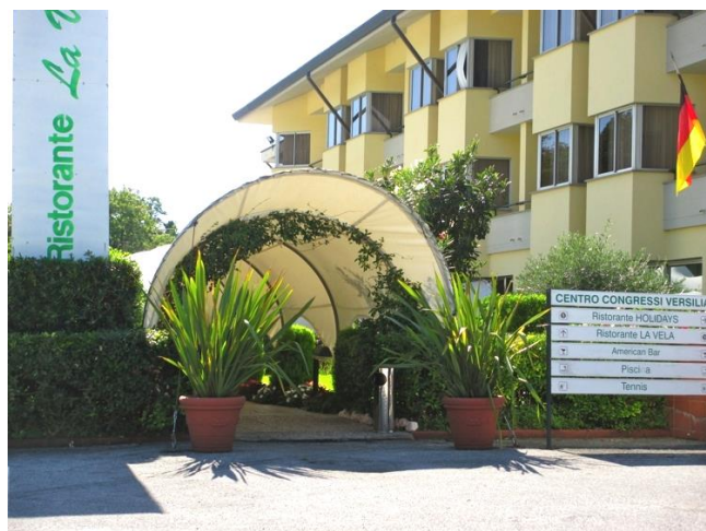
Accesso al tunnel coperto
