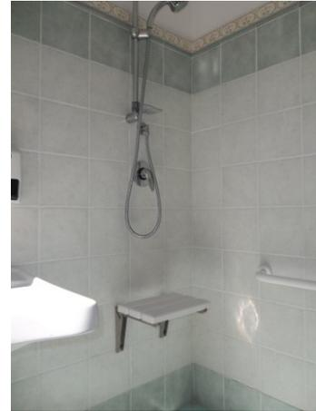
E' presente n.1 servizio igienico accessibile/fruibile dagli ospiti con mobilità ridotta. I servizi igienici sono accessibili in piano, con wc dotato di maniglione di sostegno. La larghezza utile della porta del bagno è 90 cm.
